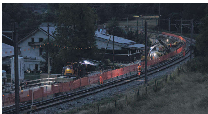
Wichtige Vorbereitungsarbeiten für den Doppelspurausbau haben begonnen
